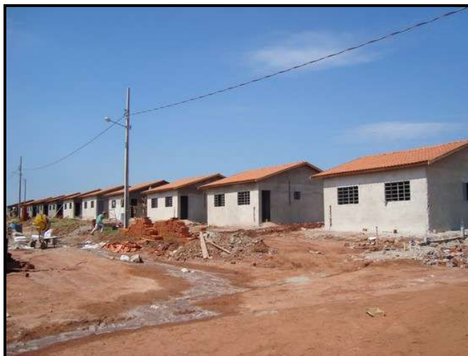
Figura 256 – Construção de moradias para funcionários da Usina Santa Terezinha em Paranacity
