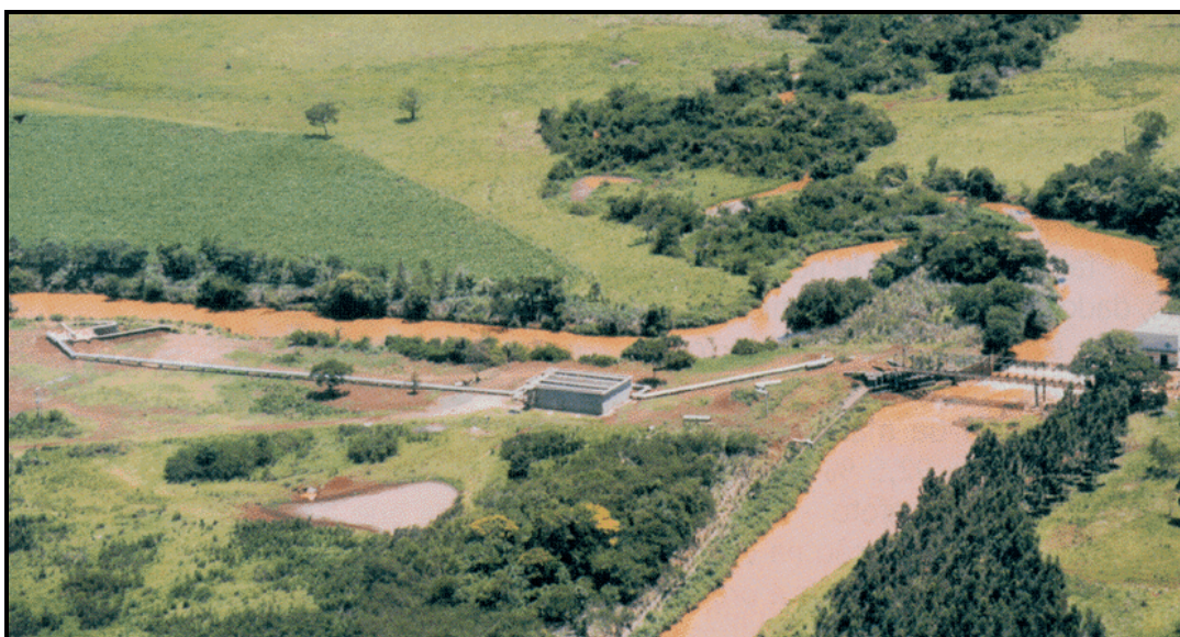
Figura 77 – Vista aérea da captação de água da SANEPAR no Rio Pirapó.
