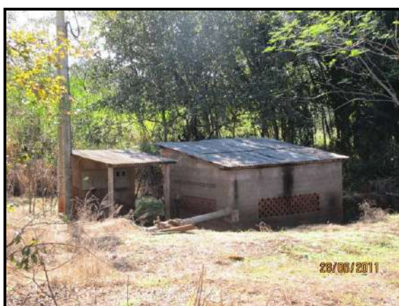
Figura 209 – Mecanismo elétrico de bombeamento de água para irrigação em fazenda na ADA. (observe poste de luz ao lado da casa de força que poderá demandar relocação).
