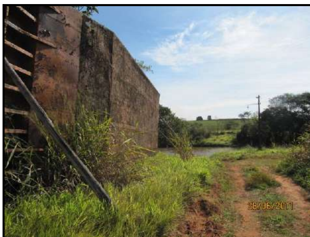
Figura 207 – Poste de iluminação junto à balsa nas margens do rio Pirapó.
