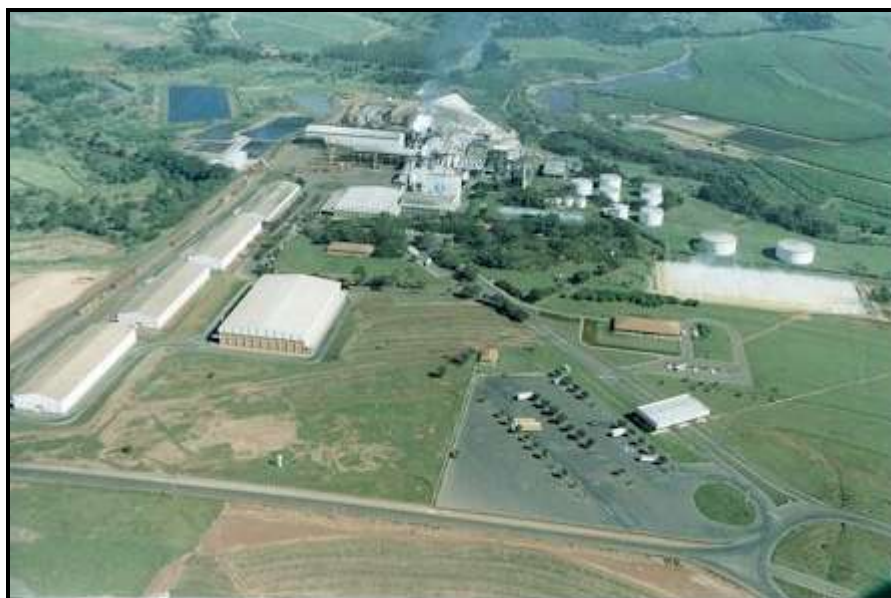
Figura 250 – Unidade de usina de álcool e açúcar no distrito de Alto Alegre.
