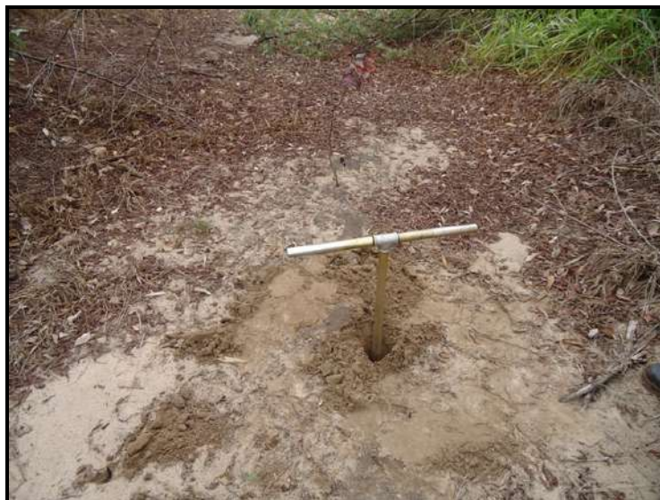
Figura 109 – Sondagem ST-03 executada.
