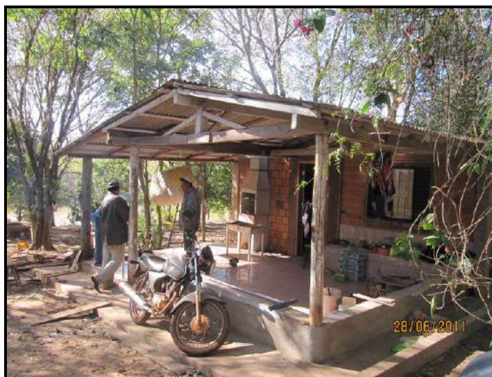
Figura 288 – Casa em reforma na Fazenda Denner
