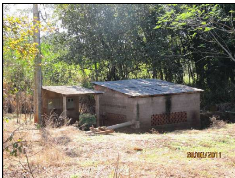
Figura 275 – Casa de força para bombeamento da irrigação
