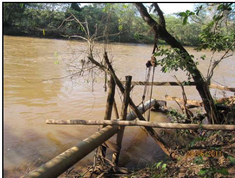
Figura 274 – Tubulação para retirada de água do rio
