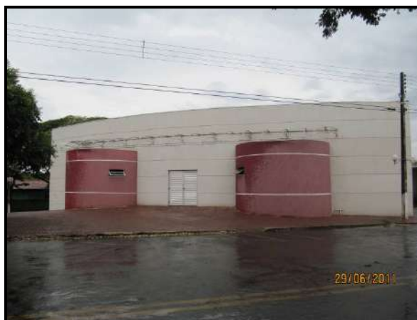
Figura 169 – Casa da Cultura de Colorado (em reformas).
