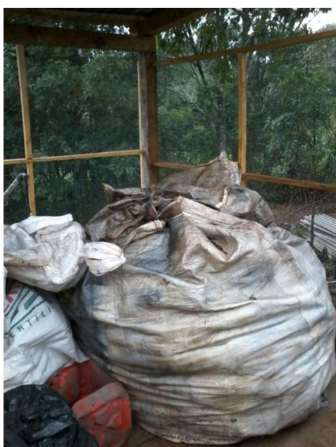
Figura 8: Armazenamento de resíduos na obra.
