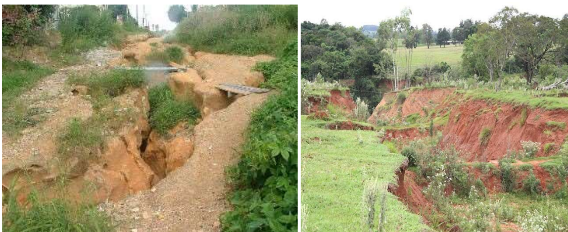
Figura 2: Exemplos de erosão em meio rural.
