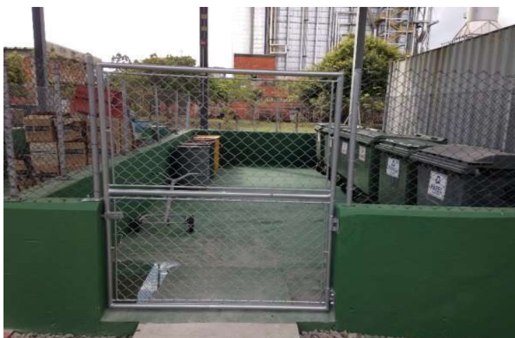
Figura 6: Armazenamento de resíduos em obra.
