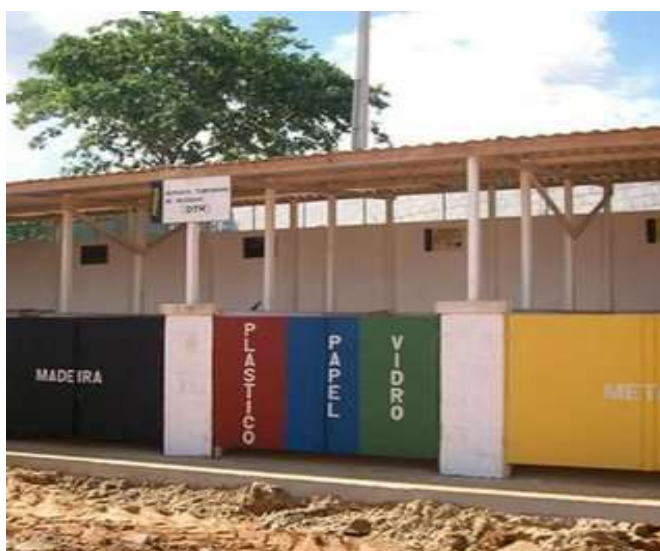
Figura 5: Armazenamento de resíduos em obra.
