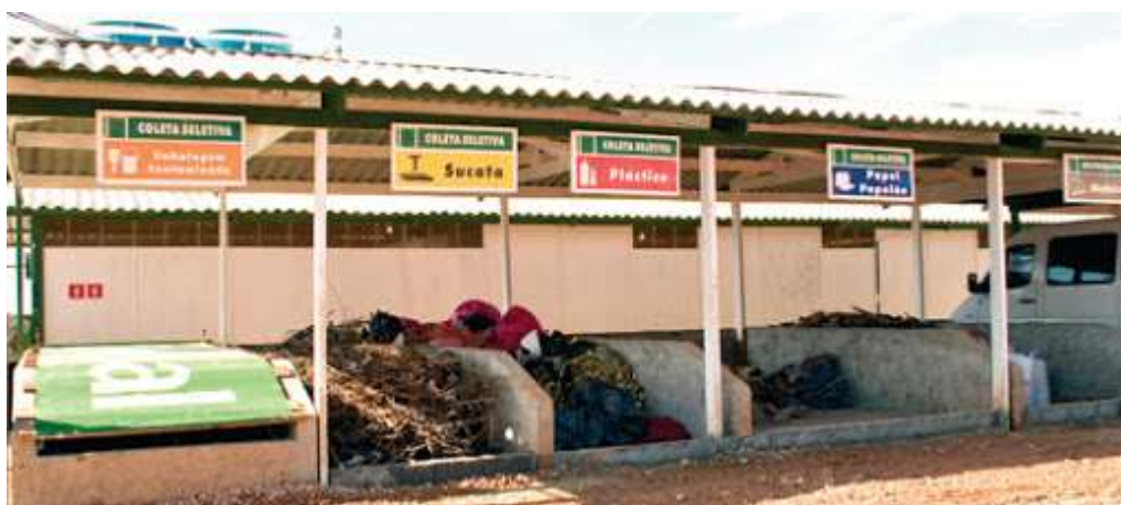
Figura 24 - Exemplo de resíduos de construção civil acondicionados corretamente em obra.
