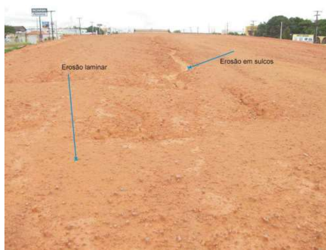
Figura 14 - Exemplos de processos de Erosão laminar.
