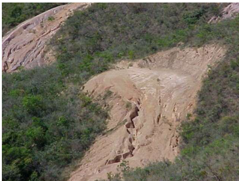
Figura 12 - Exemplo de Erosão em ravina.
