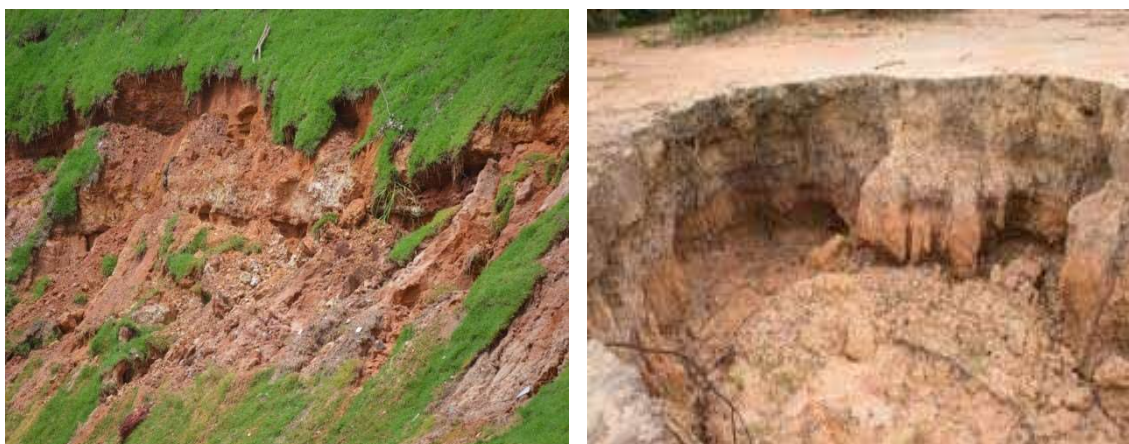
Figura 8 - Exemplos de processos de Erosão em meio rural.
