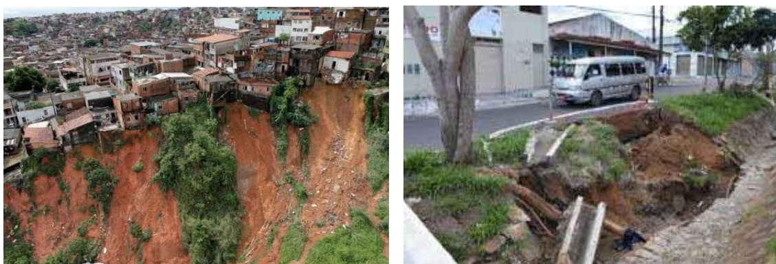
Figura 9 - Exemplos de processos de Erosão em meio urbano.
