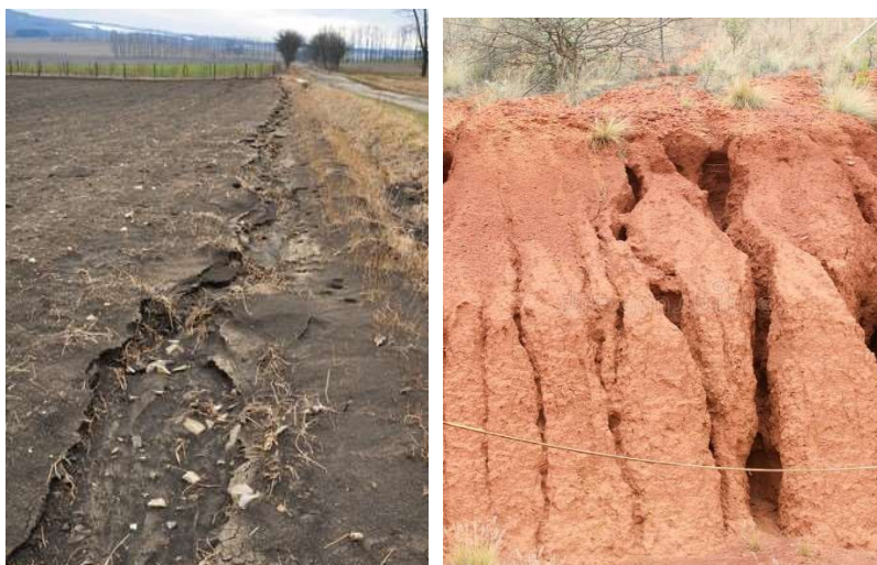
Figura 10 - Exemplo de erosão em sulcos.
