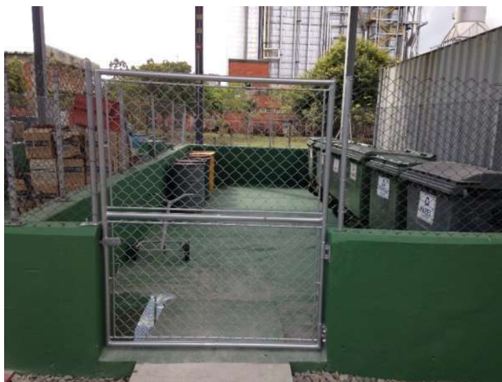
Figura 23 - Exemplo de resíduos sólidos acondicionados corretamente em obra.
