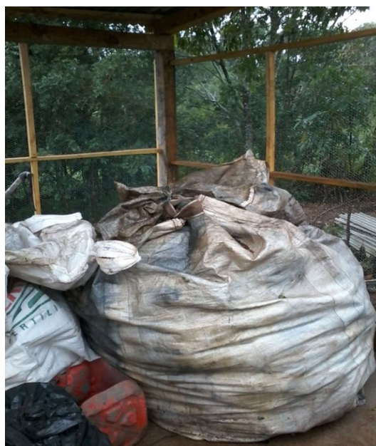
Figura 26 - Exemplo de área de armazenamento temporário de resíduos da construção civil.
